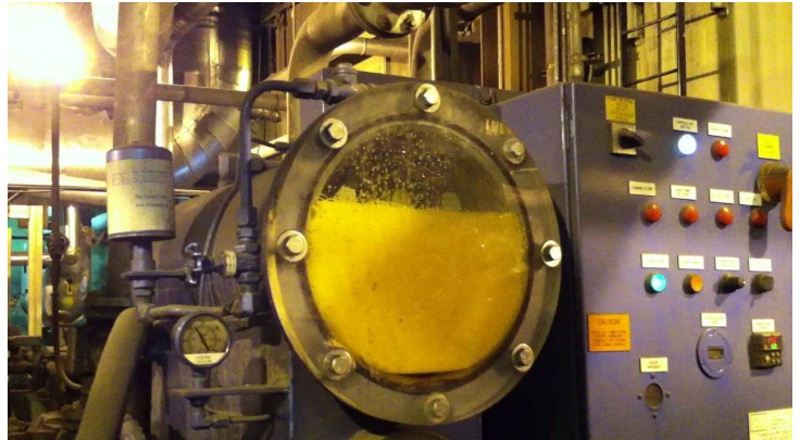
Figuras 8/9 - Ar entranhado em fluidos para sistemas hidráulicos
