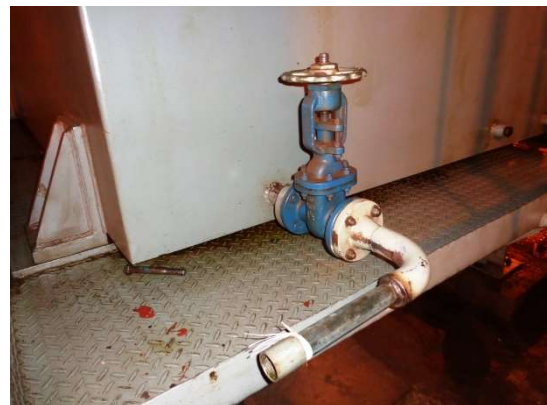
Figuras 13/14 - Limpeza ocasional e drenagem do reservatório
